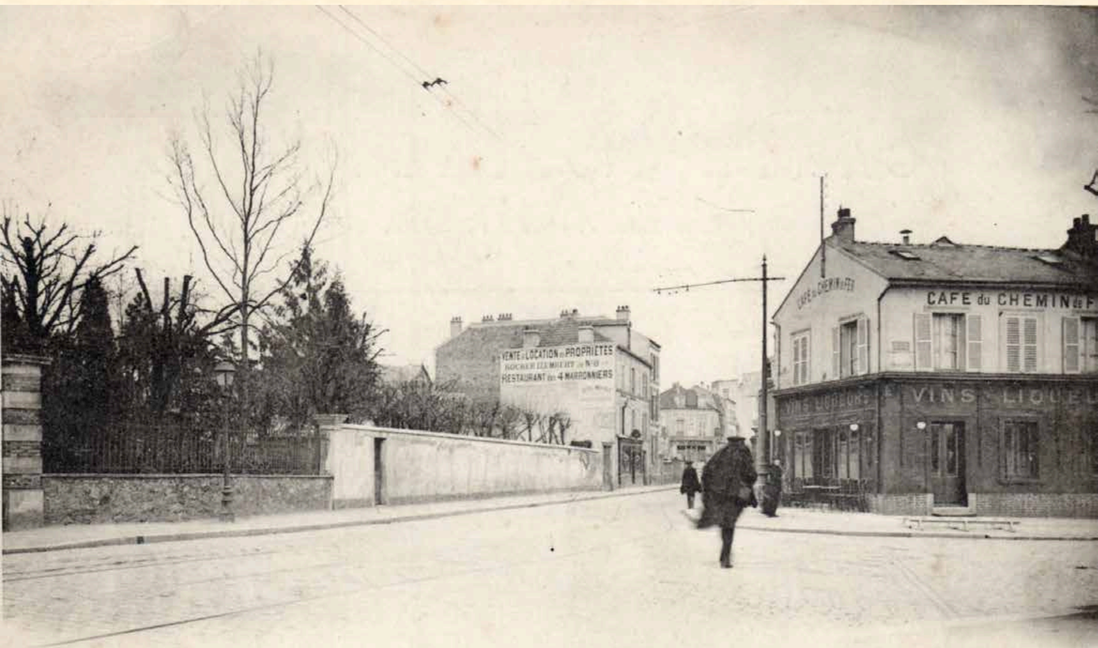
ROSNY-sous-BOIS — Rue de Nogent
