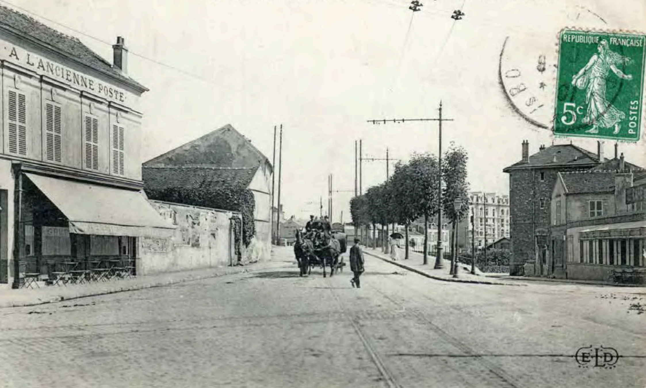
18. ROSNY-SOUS-BOIS — Entrée du pont du chemin de Fer
