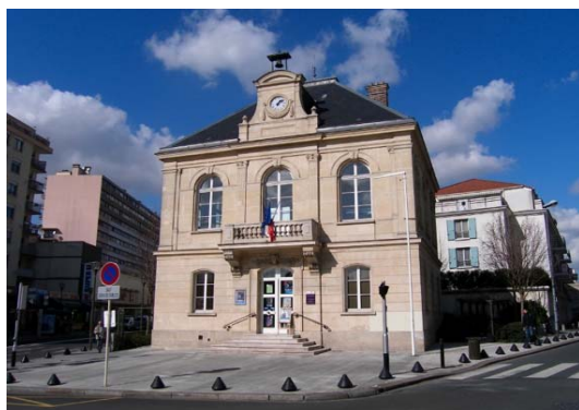
A gauche, l'ancienne Mairie ou centre André Malraux, témoin de l'architecture néoclassique, en position de tête d'îlot.
