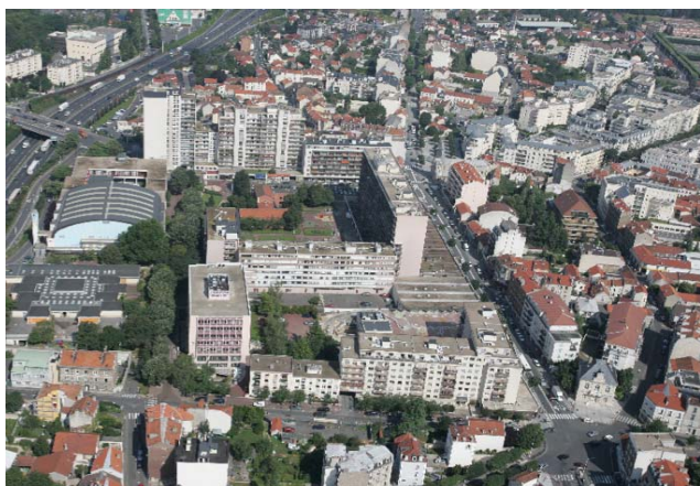
Vue aérienne du centre-ville, au centre l'axe structurant
