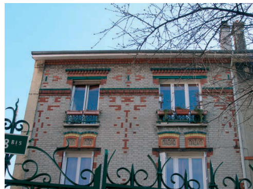
Détails de façade du 28bis en briques polychromes...jeux de frises, motifs géométriques pour bandeau, allèges, sommiers de linteaux, parements pleins.
