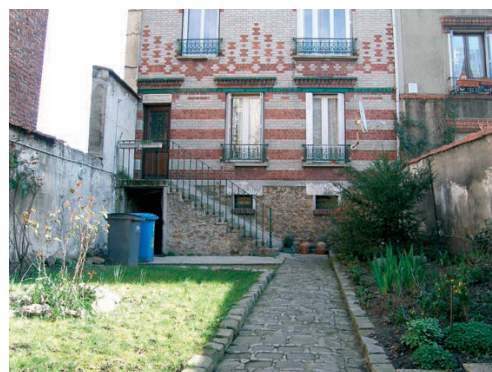
Détail de la courette et soubassement du n°28bis.
