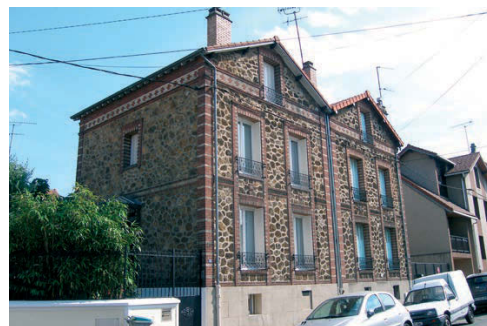
Deux façades-pignons avec façon de fronton s'élèvent sur le quartier historique.
