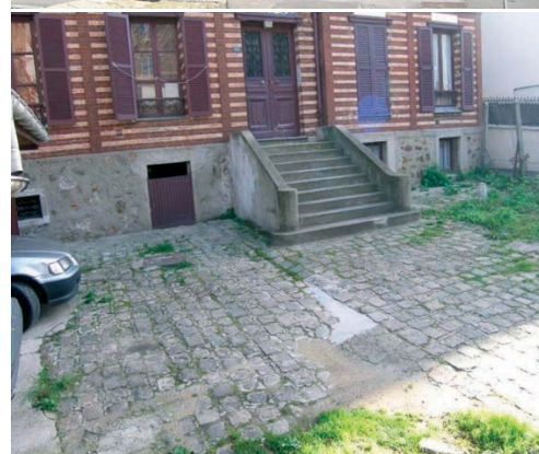
Vue de la façade principale - de la cour pavée et l'escalier menant au rez-de-chaussée surélevé.
