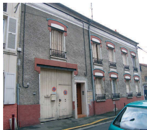
Maison de bourg, 11 rue Saint-Pierre
