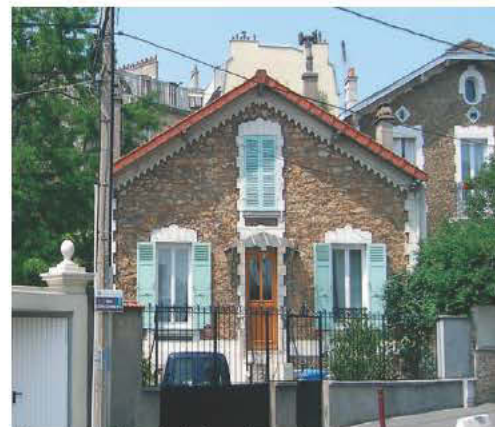
Vue rapprochée de la façade sur la rue.
