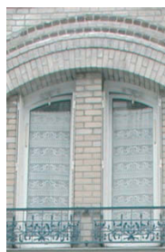
Détail du porche d'entrée et d'une ouverture à meneau central en briques.
