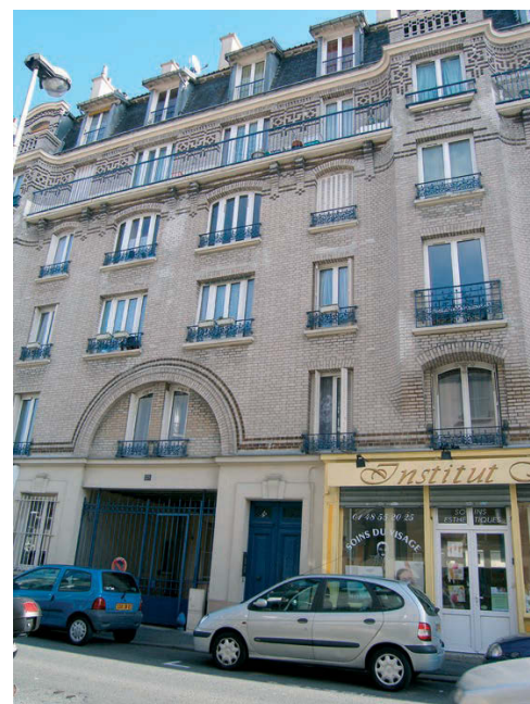
Vue de la façade principale sur rue
