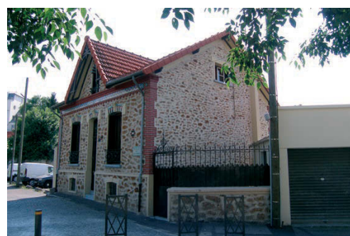
Vue de trois quarts depuis le nord. Notons la clôture attenante munie d'un mur bahut identique au vocabulaire des façades en meulière et d'une serrurerie très riche avec tôles pleines en partie basse et barreaudages finissant en épis. La porte est complètement intégrée au système décoratif de la clôture. Seules des volutes et un épi complexe en définissent le point.
