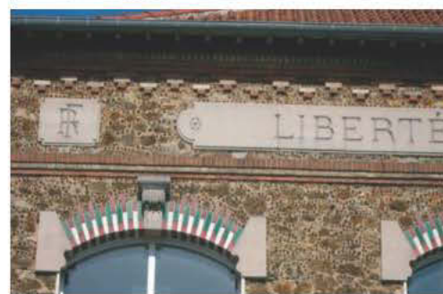
Façade principale et détails des différents matériaux
