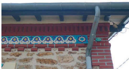
Multiplicité des décors, des matières et des couleurs (pierres, brique, vernis, céramique, zinc, enduit, etc.)
