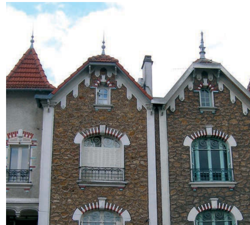
Détails du couronnement du pignon du 54-56 rue Victor Hugo avec façon de frise en enduit, consoles en bois, petite croupe, épis de faîtage en zinc
