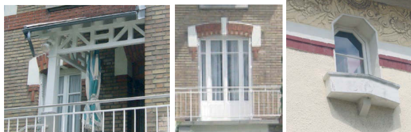
La brique apparaît sous différentes mises en œuvre : en matériau de façade, mais aussi dans l'animation de la façade : bandeau, linteau....
