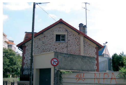
Vue de la façade nord. Derrière en façade ouest se distingue la verrière.
