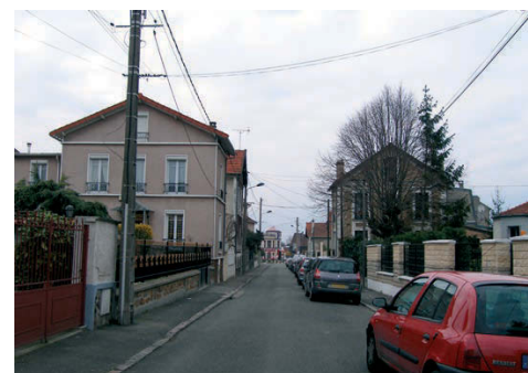
Les façades-pignons latérales ouvrent sur des jardins qui s'étirent en longueur le long de la rue. La vision latérale reste majoritaire dans la perception urbaine, a contrario de la photographie du dessus (rue des Quinconces). Cette morphologie urbaine réclame un recul important pour apprécier et voir les façades.
