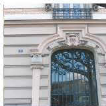
L'expression des parements des collectifs se rapproche des pavillons de banlieue.
