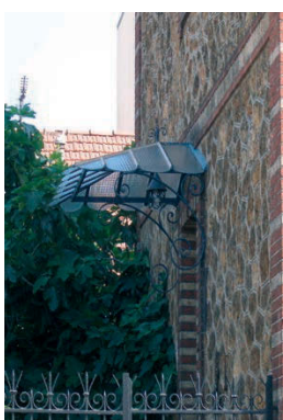
Entrée latérale avec emmarchements protégés par une marquise en serrurerie, verrière armée en éventail.
