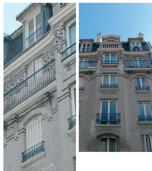
Quelques détails de la façade principale - jeux de parement de briques polychromes.
