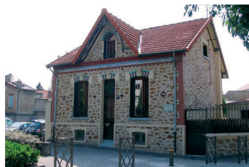
Vue de la façade principale qui donne un vis-à-vis avec la maison néoclassique du n°7 rue Saint-Claude.
