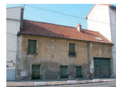
Rue de Nanteuil, ancienne ferme
