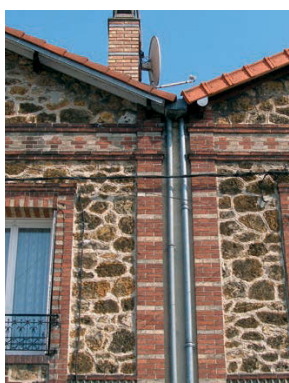
Continuité et séparation sont des thèmes récurrents de maisons jumelles. Ici le chéneau encaissé et les descentes d'eaux pluviales tracent la limite. Notons les rives dissymétriques.
