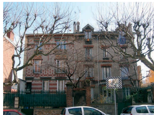
Vue depuis la rue des deux façades en brique mitoyennes en arrière d'une clôture maçonnée montée sur mur bahut.
