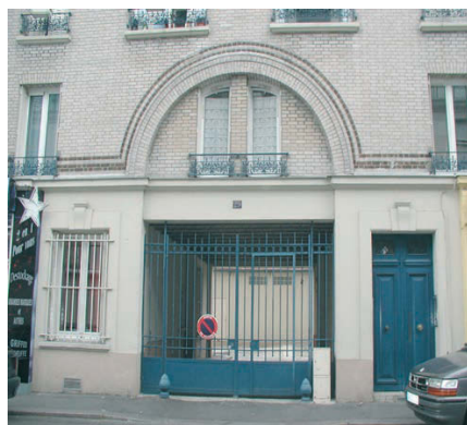
Détail du porche d'entrée et d'une ouverture à meneau central en briques.
