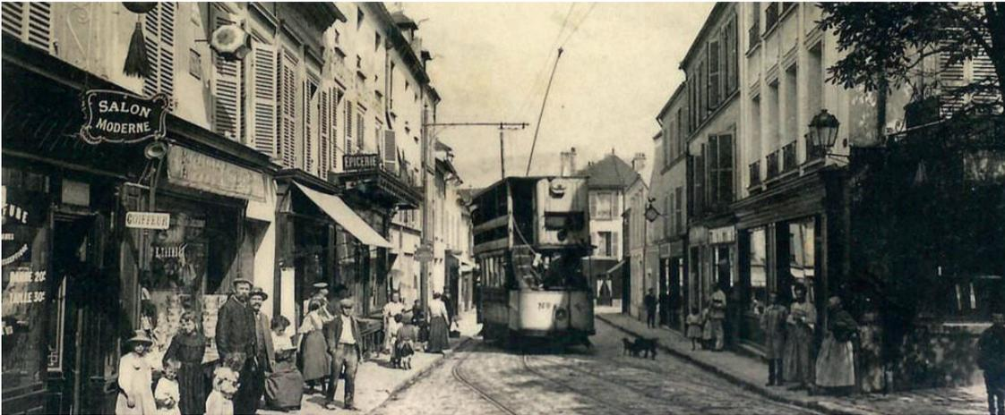
L'installation de ce réseau a nécessité la pose de rails sur les chaussées et de lignes électriques aériennes, les motrices s'y alimentent par une perche.
