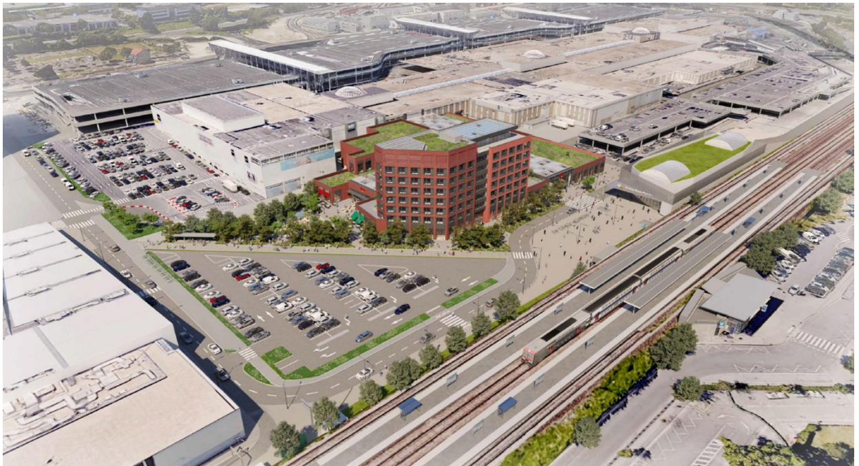
Figure 1 : Vue de de la future extension de Rosny 2
